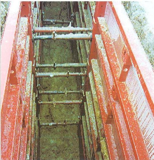
**Lagenweises Verfüllen und Verdichten**
