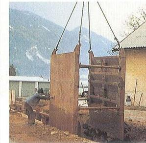
**Umhüllungs-beton für die Rohrleitung** Die Schneidenplatte mit glatter Innenwand dient als Schalung. Sie kann nach dem Betonieren gezogen werden.
