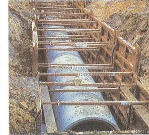
**Verlegung von Großrohren** auf einer Betonsohle, die den Verbau abstützt. In diesem Fall ist eine Hakenschraube im untersten Plattenstoß erforderlich.
