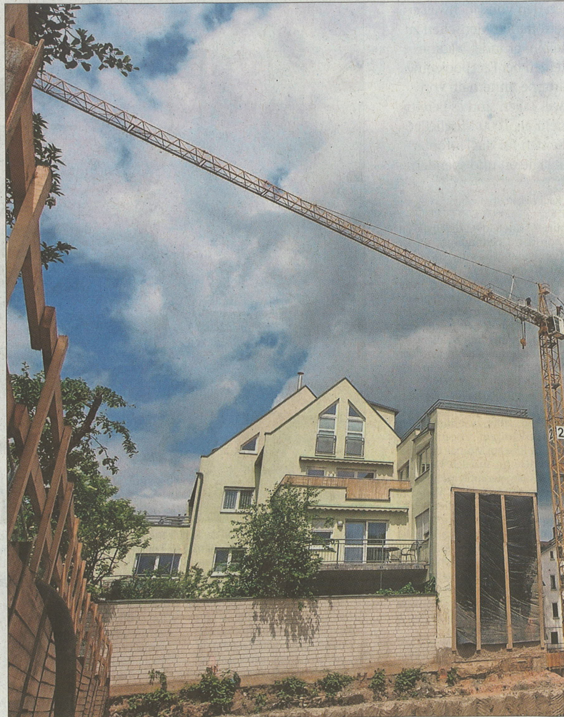
Der Kran steht: Gestern ist das knapp 50 Meter hohe Gerät in der Baugrube für die Tiefgarage in der Ketschenvorstadt aufgebaut worden. Der Ausleger und der Gegenballast wurden per Autokran in die Höhe gehievt. Foto: Sven Lindner
